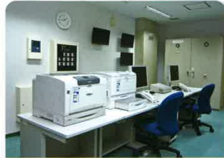
●中央監視室 施設内の各機器の運転状況を示すオペレータコンソールや監視用モニタなどにより、集中管理と遠隔操作を行います。
