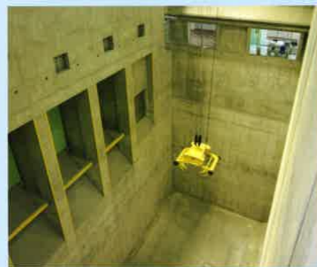
●ごみピット・ごみクレーン ごみピットに投入したごみは、ごみクレーンでよく攪拌し、ごみホッパに投入します。
