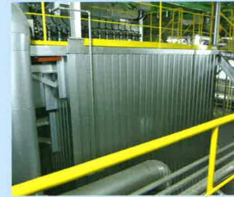
●集じん装置 排ガス中の飛灰は、この集じん装置で取り除きます。
