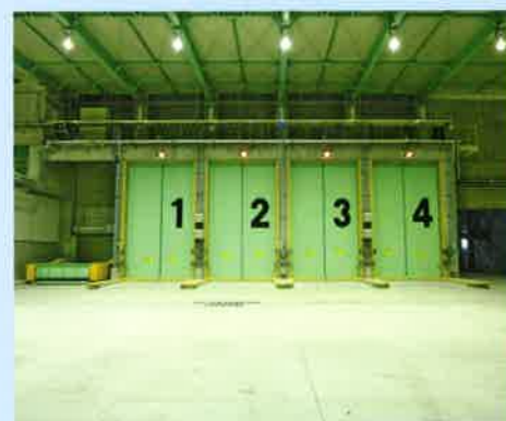
●プラットフォーム 搬入されたごみを、ごみピットへ投入します。
