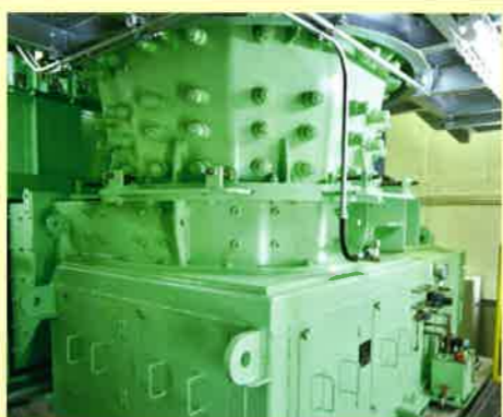
●二次破砕機 一次破砕されたごみを15cm程の大きさに小さく破砕します。
