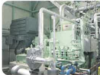
●蒸気タービン発電機 ボイラによって蒸気をつくり、タービン発電機によって電気をつくります。
