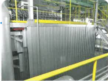
●集じん装置 けむりの中のごまかいチリをとり、けむりをきれいにします。
